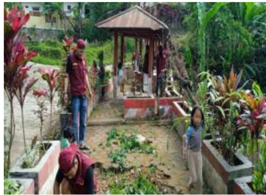
Gambar 1. Perbaikan struktural gazebo
