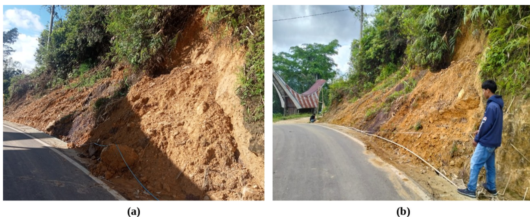
Gambar 1. Kondisi Tebing Longsor pada Ruas Jalan Malakiri–Karua STA 11+800: (a) Tebing Longsor di Tepi Badan Jalan; (b) Bidang Longsor Dilihat dari Arah Jalan
