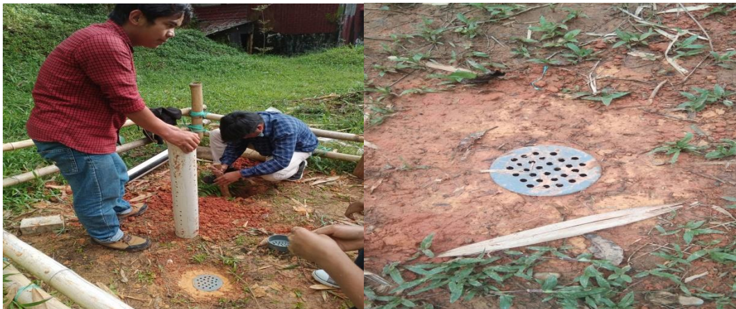
Gambar 1. Pembuatan lubang dan hasil pemasangan biopori
