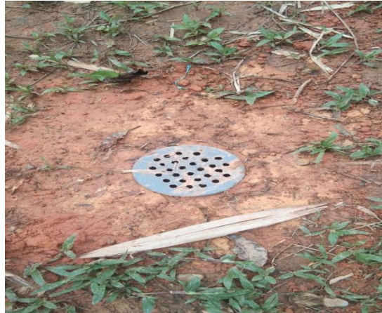
Gambar 2. hasil pemasangan biopori di tanah
